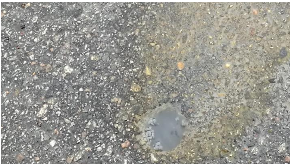
Figur 5.1: Borrhunkt NC4, artesiskt grundvatten.
