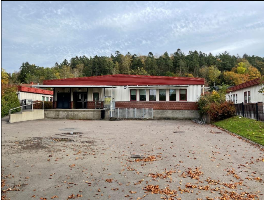
Bild 5.4 Centrala/norra delen, befintlig skolbyggnad, vy mot öster.
