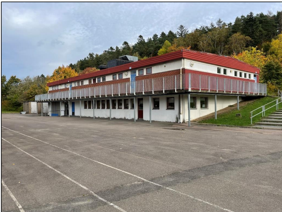
Bild 5.3 Östra/sydöstra delen, befintlig skolbyggnad, vy mot norr.
