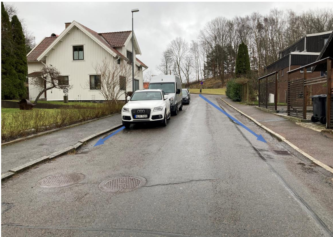
Figur 12. Befintliga dagvattenbrunnar i Våggatan söder om planområdet (Foto: Atkins, 2022-02-17).
