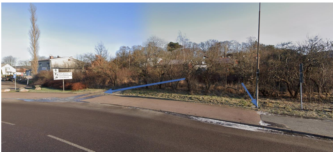
Figur 11. Avrinning från Åby 1:93 mot befintlig gångcykelbana (Foto: Atkins, 2022-02-17).
