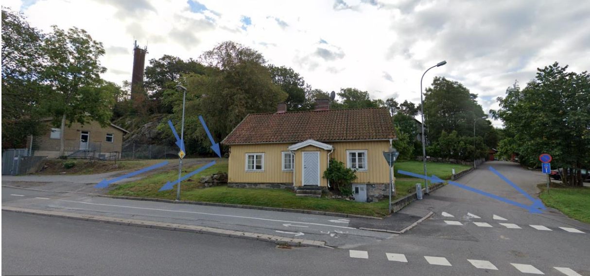
Figur 8. Delavrinningsområde B som rinner mot fastighet Noten 13 där gula villan idag är placerad (Foto: Atkins, 2022-02-17).
