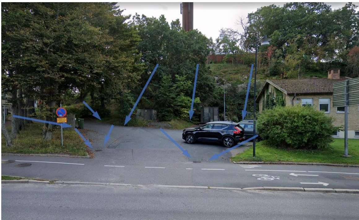
Figur 7. Hårdgjord yta inom avrinningsområde A som avvattnas mot befintliga dagvattenbrunnar inom fastighet Noten 13 samt ut mot gångcykelbana (Foto: Atkins, 2022-02-17).
