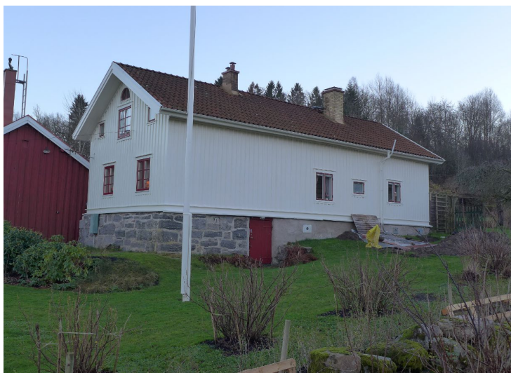
Huvudbyggnaden på den gård som är utpekad som kulturhistoriskt värdefull söder om Heljered's byväg, vid korsningen med Hålllevägen.
