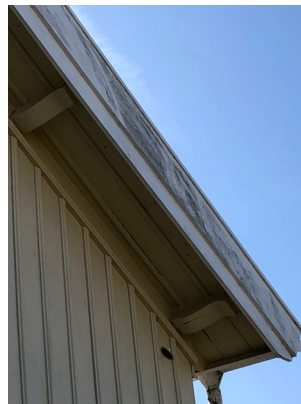
Öppen takfot med taktassar.
