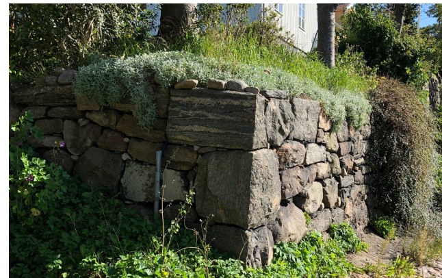
Terrassmurar tar upp nivåskillnaderna.
