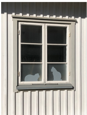
Fönster med fasta spröjs.
