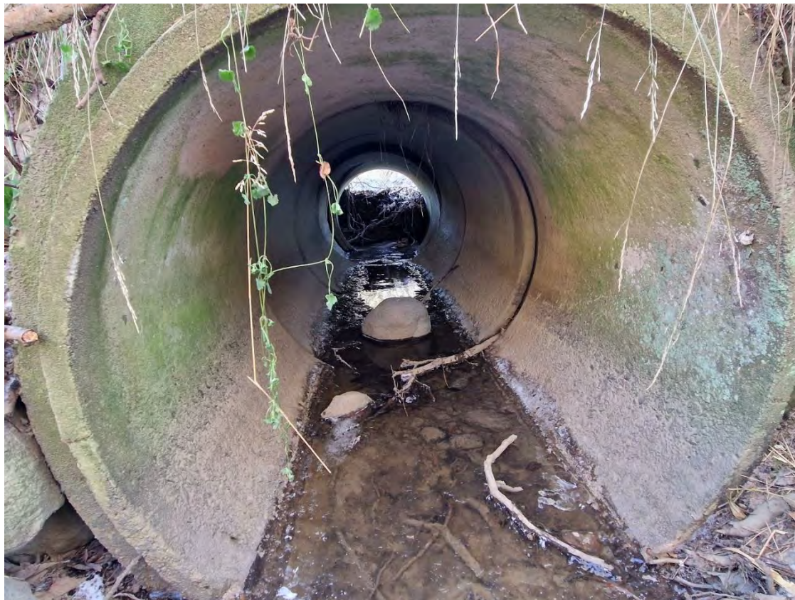
Figur 38. Åtgärdsförslag 16 – Utrivning av trumma.
