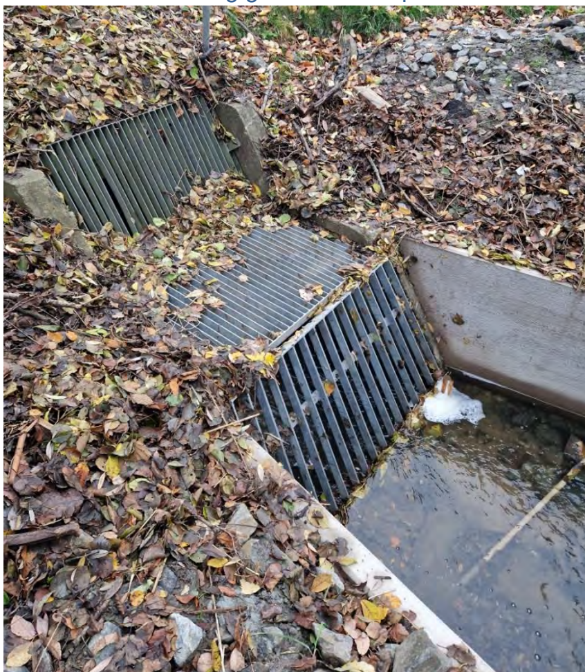
Figur 32. Åtgärdsförslag 10 – Utrivning av galler.
