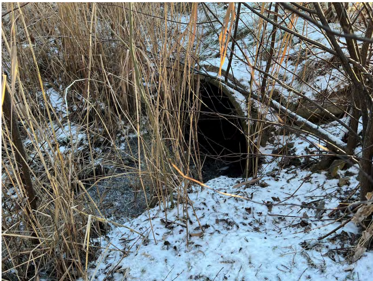
Figur 36. Utrivning av trumma.
