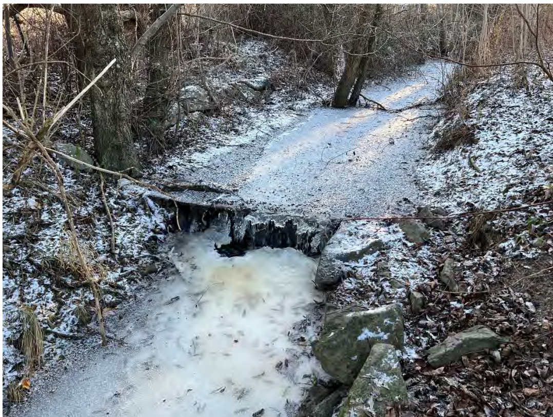
Figur 34. Åtgärdsförslag 12 – Utrivning av dämme.
