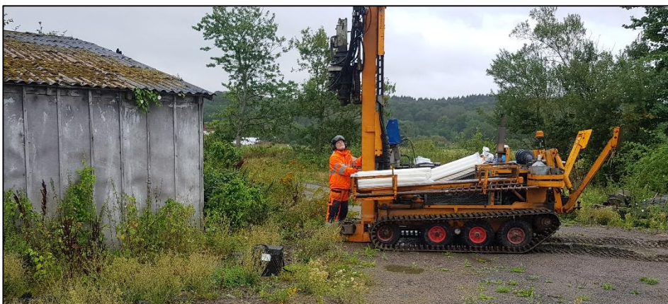
Figur 6.2 Installation av grundvattenrör i provpunkt NC1902.
