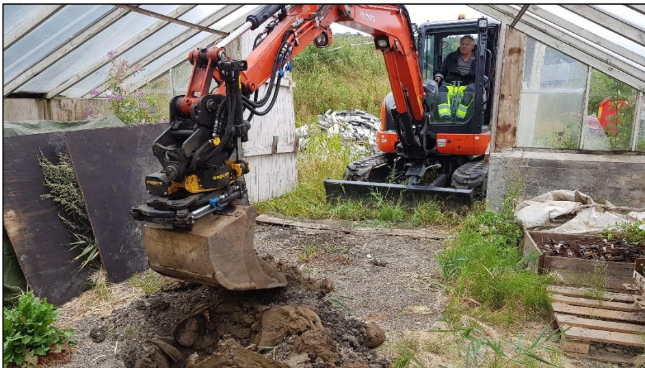
Figur 6.1 Provgropsgrävning med grävmaskin i provgrop NC1911 i Växthus 1.
