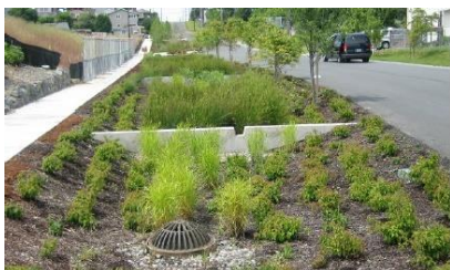
Typexempel på dagvattenhantering på Åbybergsgatan. T.v. regnträdgård mellan gata och gångväg. T.h. genomsläpplig rasterbeläggning för parkeringsplats (DU, bilaga 2, Markera).
