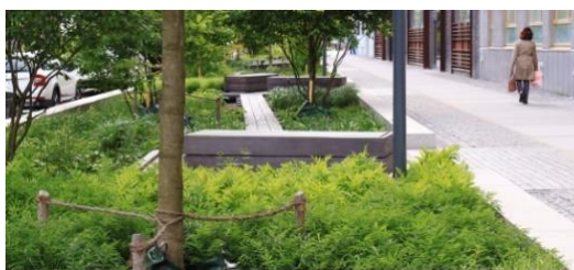
Exempel på infiltration av dagvatten, Utdrag ur bilaga 2, Dagvattenutredning, Markera .
