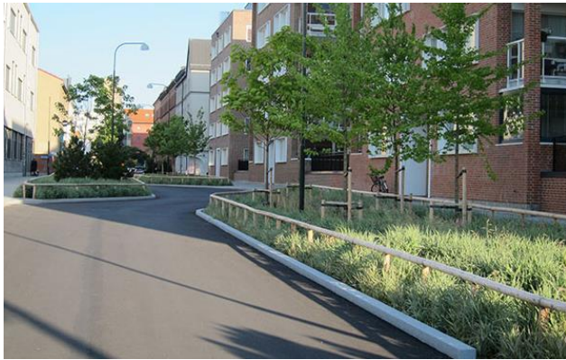
Typexempel för gestaltning av gata ihop med dagvattenhantering på Åbybergsgatan.
