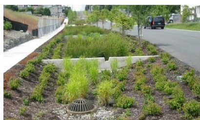
Exempel på infiltration av dagvatten, Utdrag ur bilaga 2, Dagvattenutredning, Markera .
