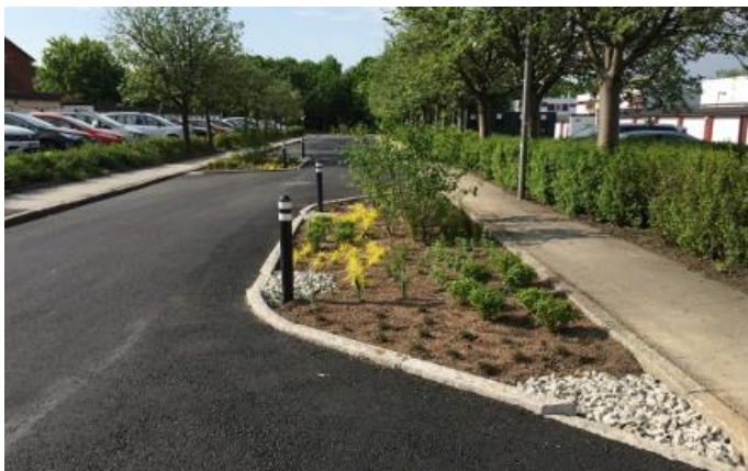
Principexempel för Åbybergsgatan samt Villagatan med ytor för möblering och dagvatten-hantering i gata som även bidrar till sänkta hastigheter.
