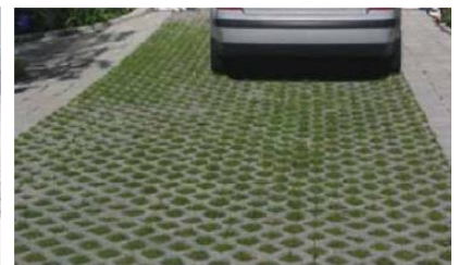
Typexempel på dagvattenhantering på Åbybergsgatan. T.v. regnträdgård mellan gata och gångväg. T.h. genomsläpplig rasterbeläggning för parkeringsplats (DU, bilaga 2, Markera).
