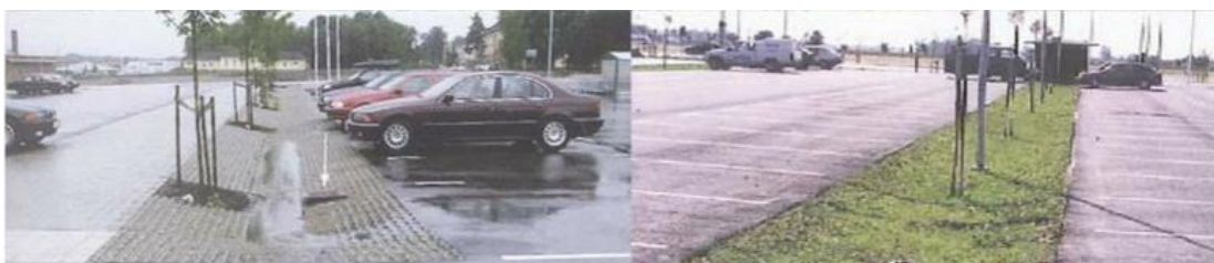
Figur 5.2. Makadamdike på parkeringsplats
