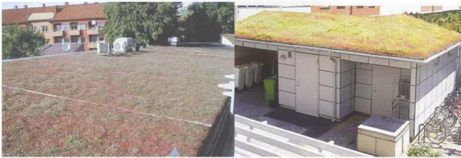
Figur 5.4. Lösningförslag till takytor för dagvattenhantering
