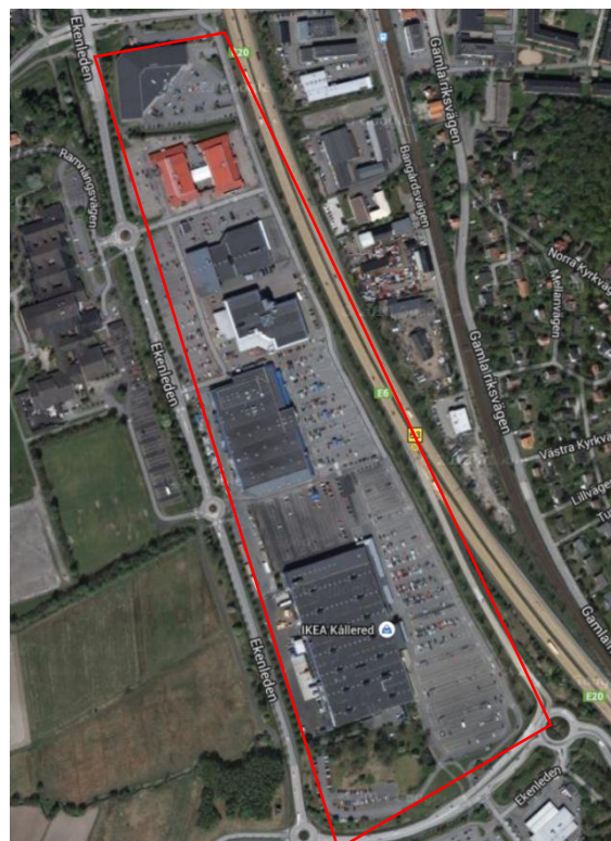
Figur 1.1. Aktuellt område innan byggnation
