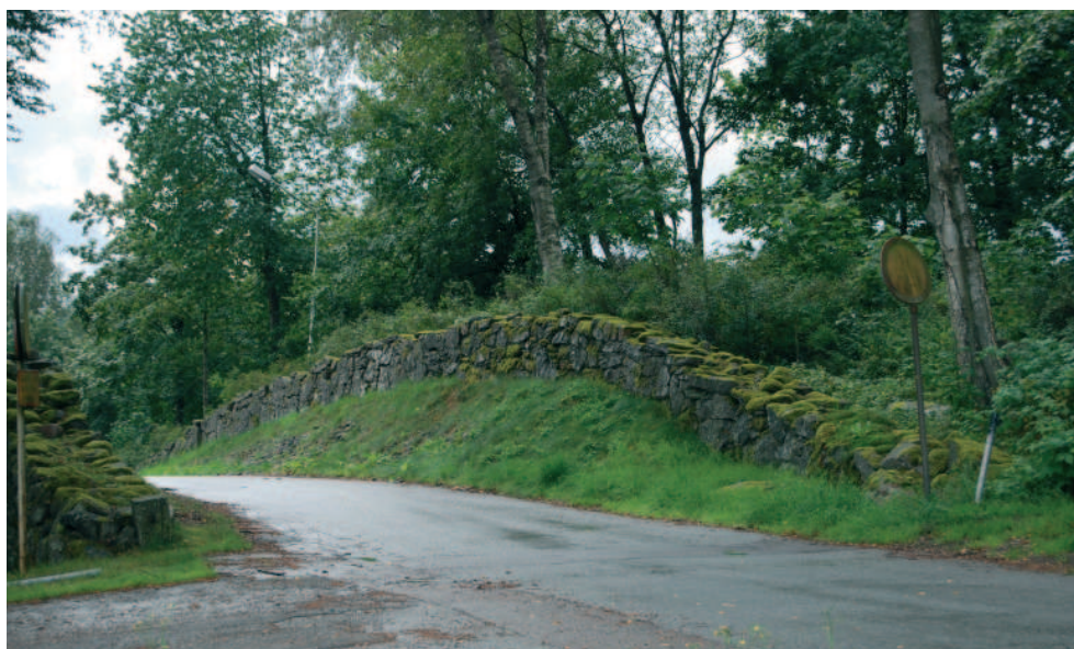
Gammal naturstensmur på Stenmursvägen.
